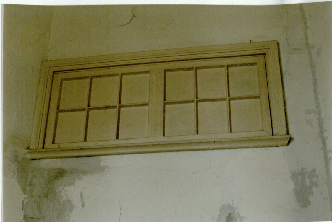
74. Aken ruumis nr. 48. A. Heina foto, 2000.
