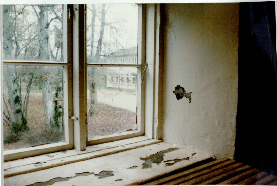
75. Aken ruumis nr. 52. A. Heina foto, 2000.
