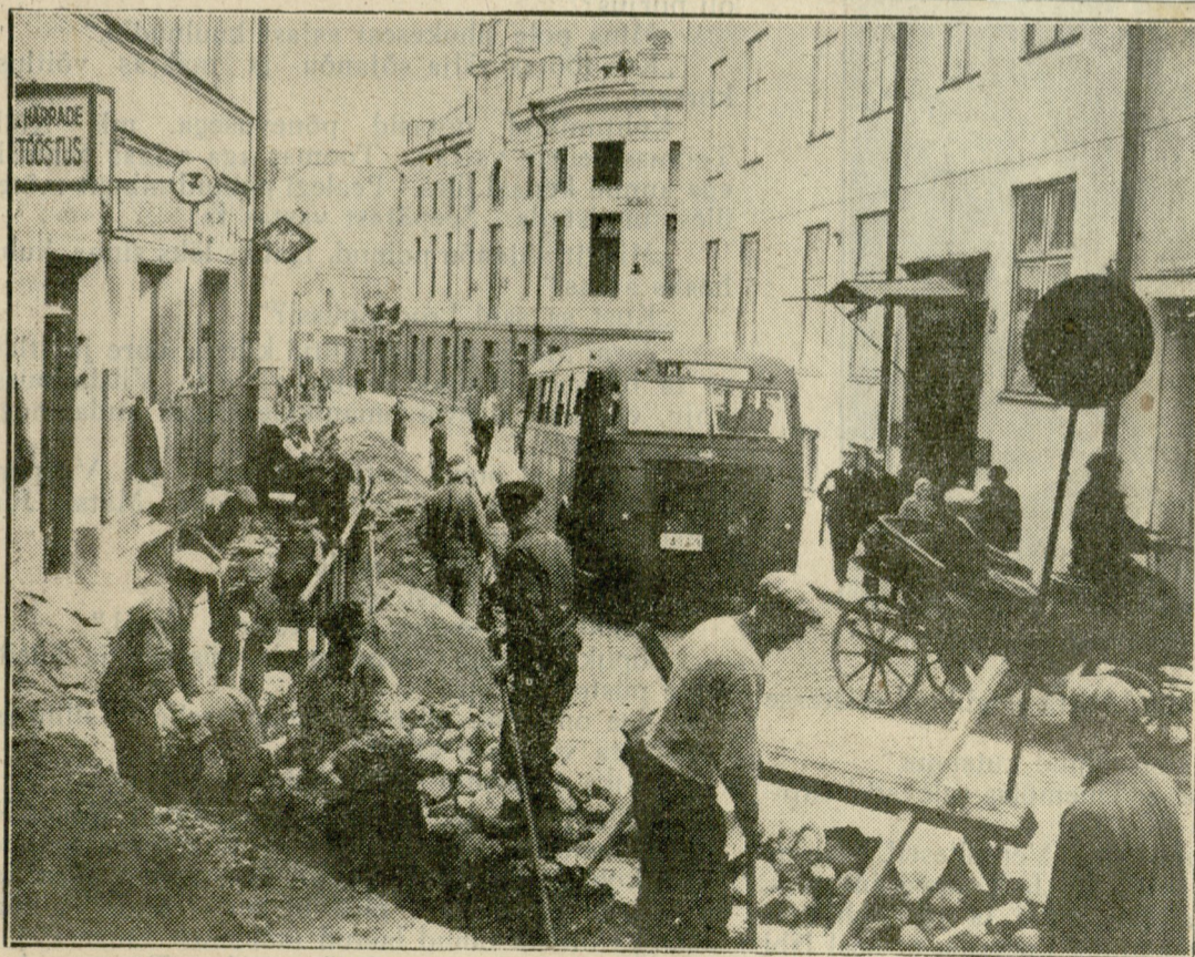
Ehitus- ja korraldustööd linnas. Liiklusnäda lõppedes algasid linnas mitmes kohas kõnniteede parandamise ja kaablipanemise tööd. Pildil näeme kaevamistöid kaablipanemise otstarbel Nunne ja Pika tänava nurgal. Kuna siin valitseb elav liiklus ja kõnnitee on kaevamisel jäänud mulla alla, siis on jalakäijad sunnitud tarvitama sõiduteed või käima ühel pool kõnniteel. Sõidukeidki jäi tee kitsikuse pärast toppama. Kodanikud loodavad, et kaabli panemine teostatakse siin kiires korras. Täna oligi hulk mehi tööle ja töö näis arenevat hooga.
