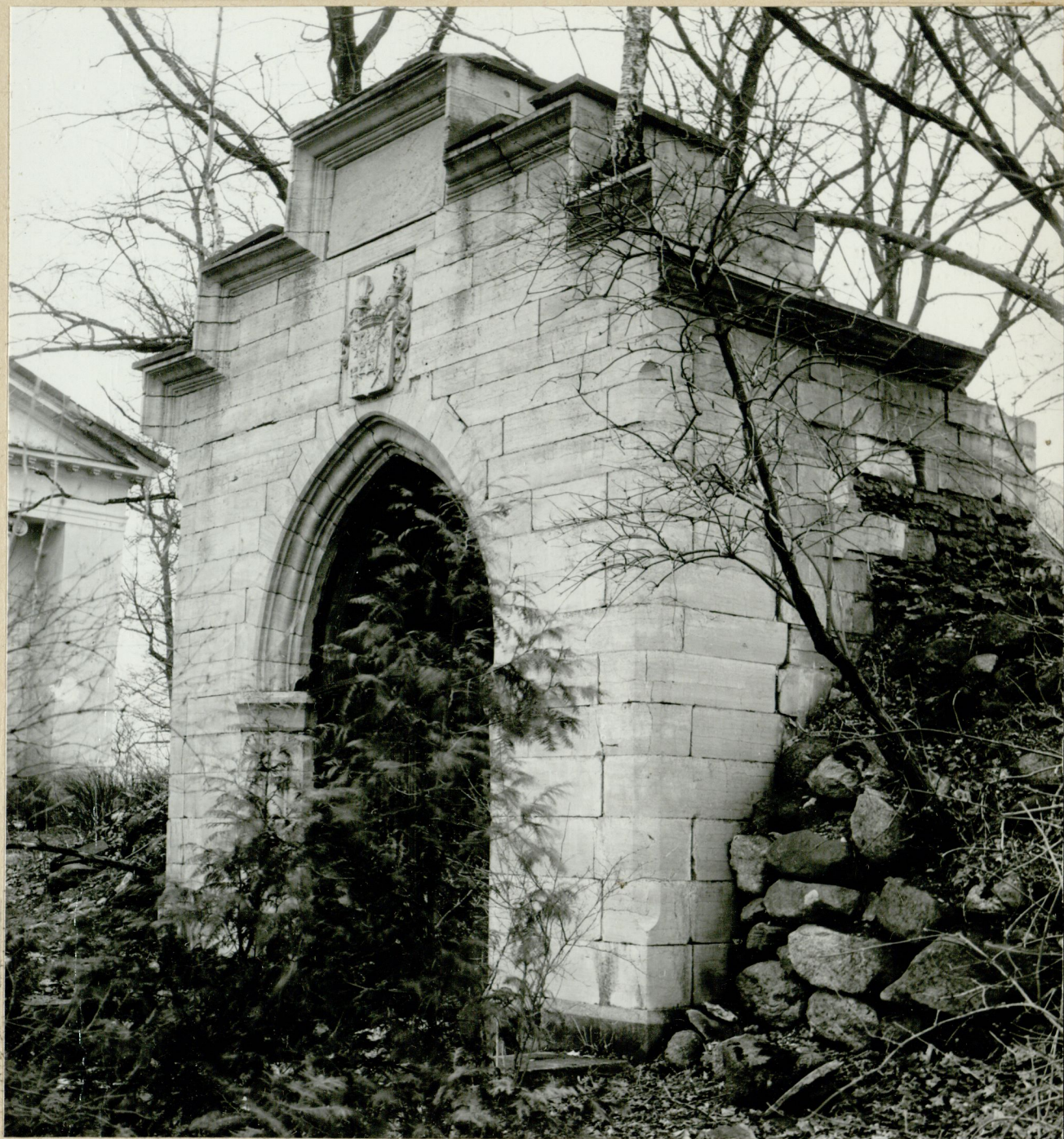
8. End. Ohtu mõisa (Meyendorffide) uus kabel. Üldvaade kirdest. VHV. Foto V.Raam apr. 1973.a. N-I4447/2
