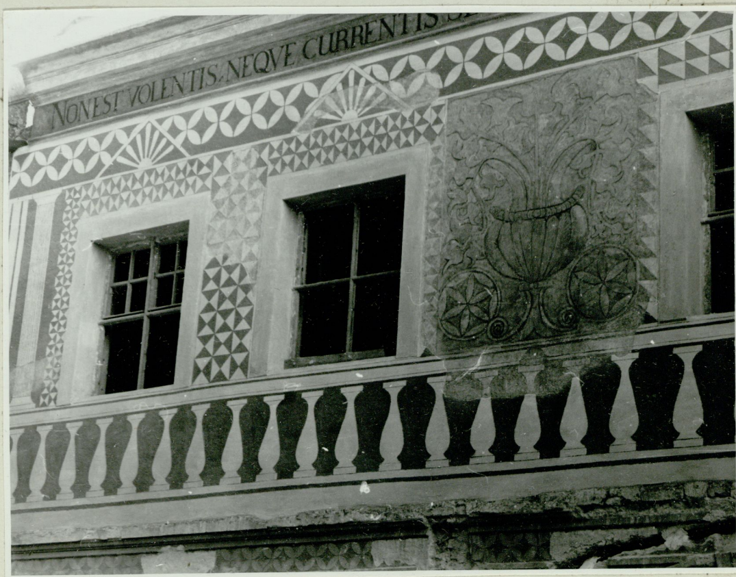
28. Kőszeg. Scafitotehnikas seinaornamentide restau- reerimine ühel linnamaja fassaadil.
