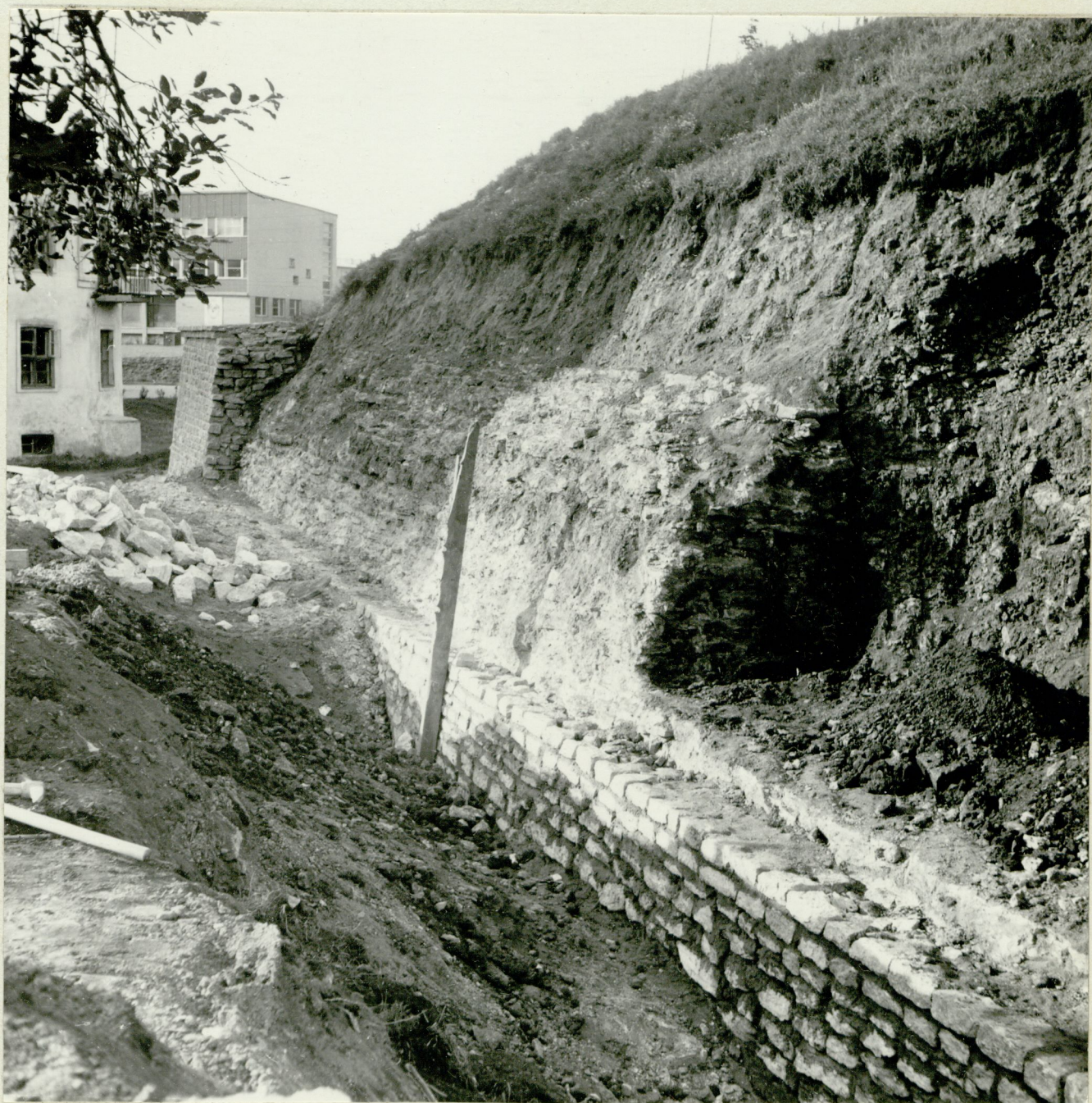
Foto Nr. 4 Bastioni "Triumph" edelakülje linnepoolne osa. Mõistise voodri teostamine. Esiplaanil näha hilisem läbimurre bastioni mõistises. Foto R. Valdre 1973.a. VRV N-15221
