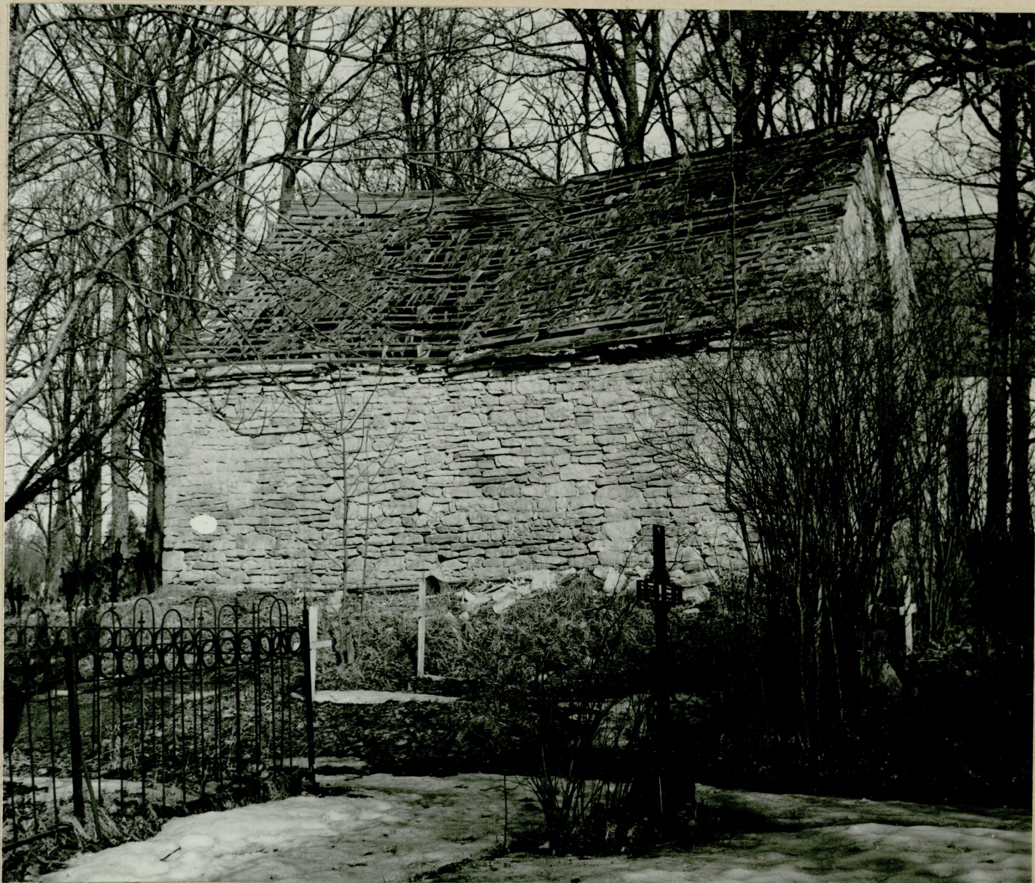
5. Kirikualokabeli tagumine külg puurägasliku raamistuses.
