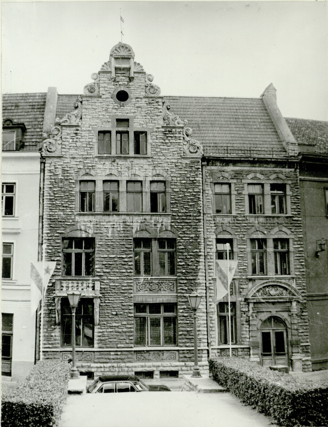
18) Таллин, ул. Харью 9. Фасад.
