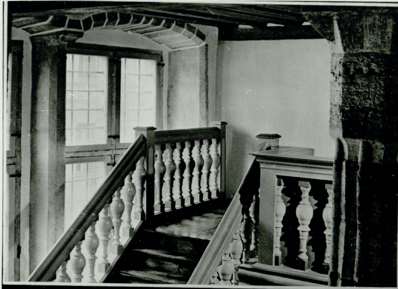
Vestibüüli trepp Лестница вестибюля
