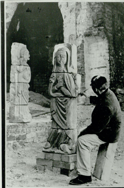
Terrakotta figuride puhastamine
