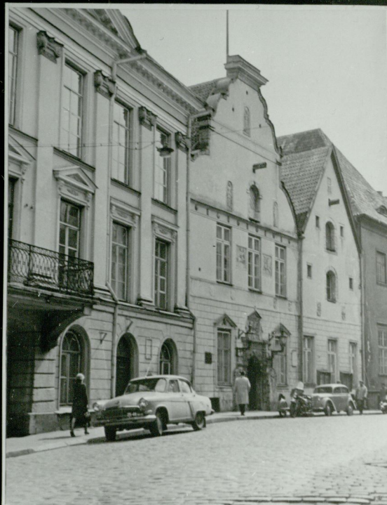
Mustpeade fassaad 1597 Foto: Kõlvart
