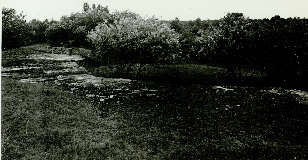
I ST. Betoneeritud eesvall. Näha otsetabamusest SÖRU-1 mardunud betoonplaat.
