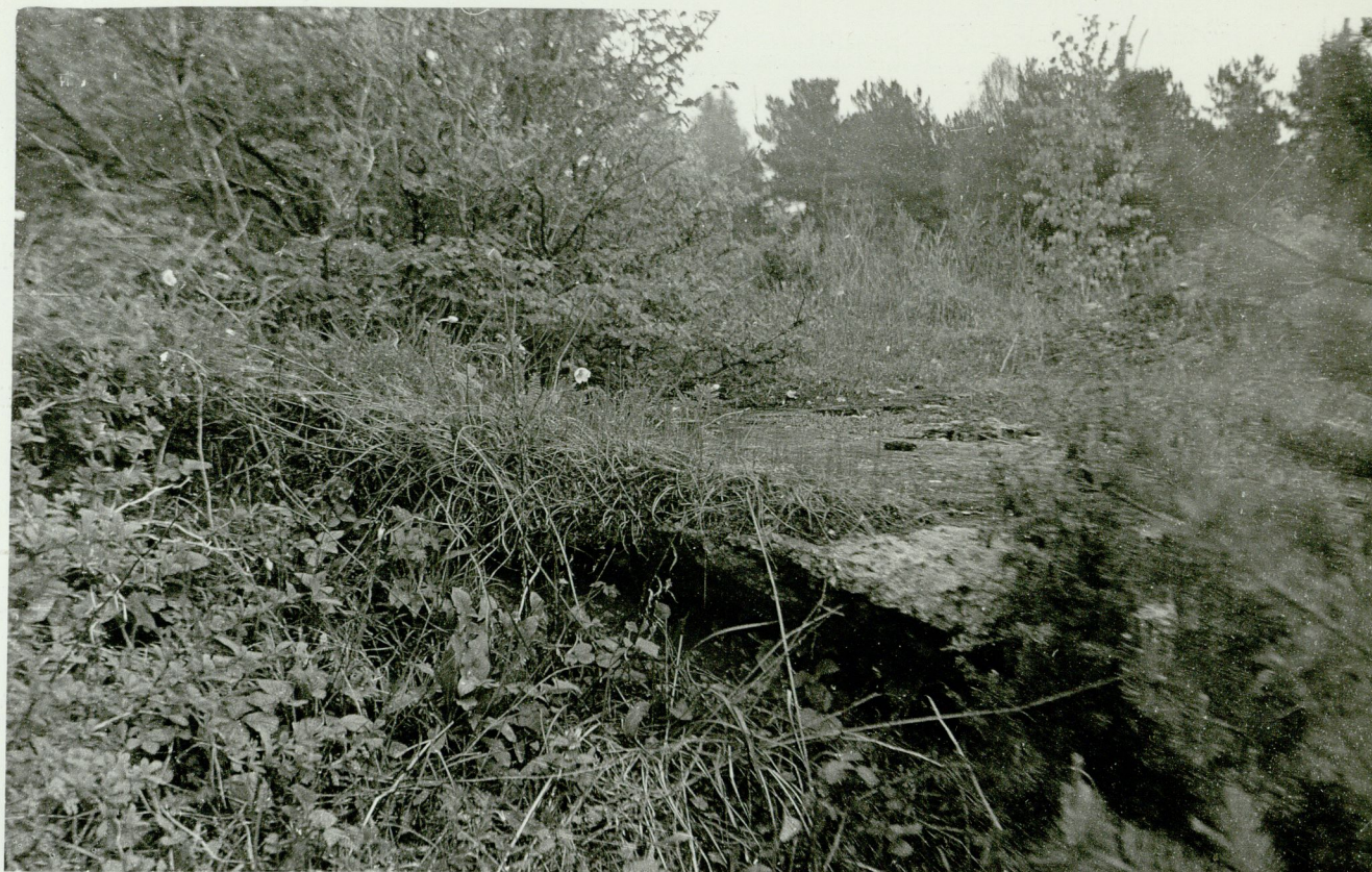
VIRT.-1 6 n patarei N o 33, IV ST. positsioon. Vaade suurükkiõuelt üle eesvalli. Eesvalli paiktugistus lammutatud, eesvall varisenud ja betoonplaat murdunud.
