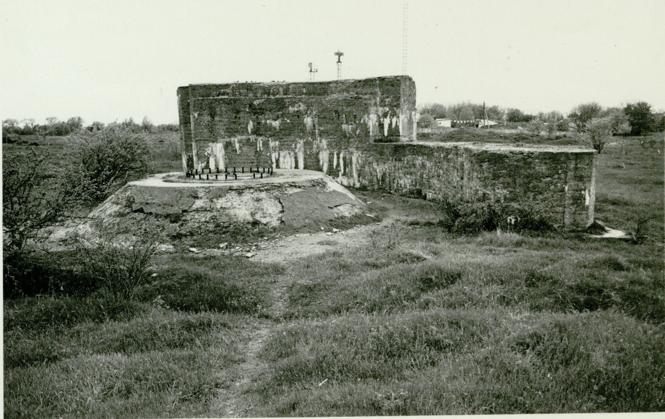
SÖRVE-1 12"-patarei N o 43, III ST. betoonalus ja kaitsesein. Seina betoneerimine lõpetamata. Foto P. Kraas 1986
