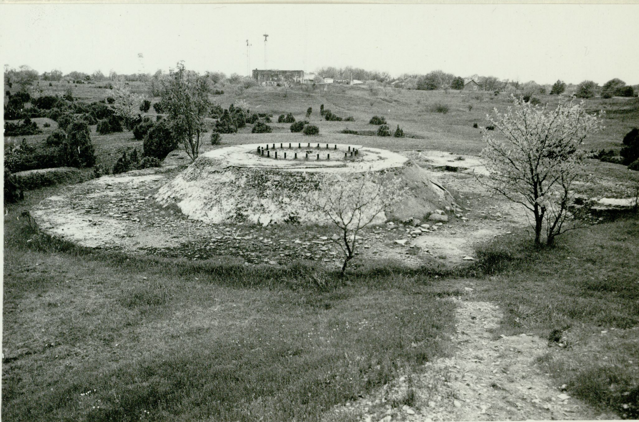
SÖRVE-1 12"-patarei N o 43, III ST. betoonalus ja kaitsesein. Seina betoneerimine lõpetamata. Foto P. Kraas 1986
