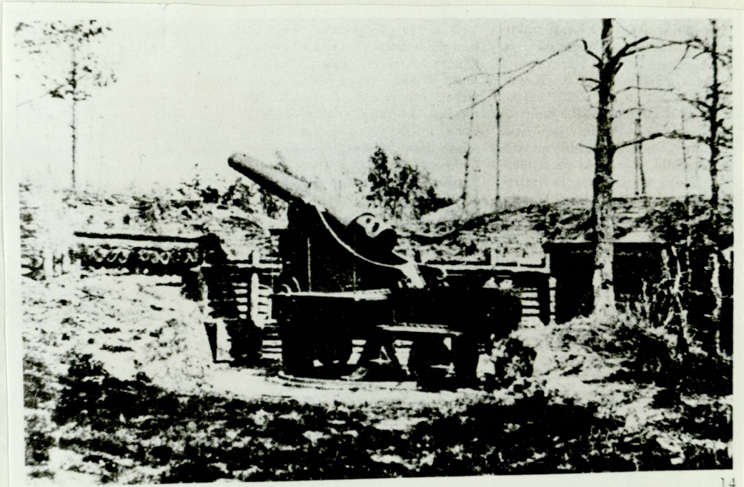
KUVA 28. Tykkiasema, jonka rintavarustus on hirsivahvisteinen. 14
