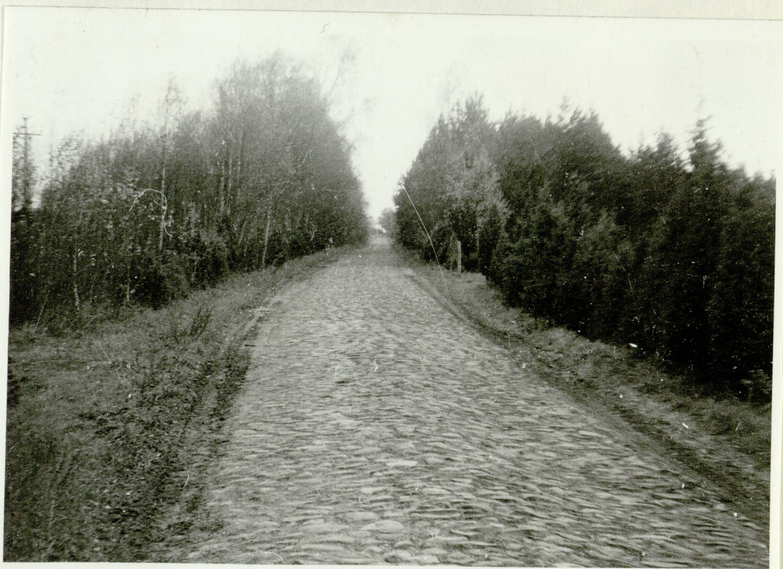
Foto 47 Kindlustee. Muhu saarel Kuivastust Voi külasse. Näha sarnasus tee konstruktsioonis kui teostuses. Tööde kvaliteet tundub Muhus parem olevat. Foto M. Kangro 1985.a.
