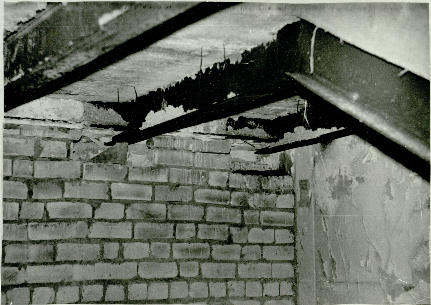
Рис. 49 Опирание кососудов на отметке 2-го этажа.
