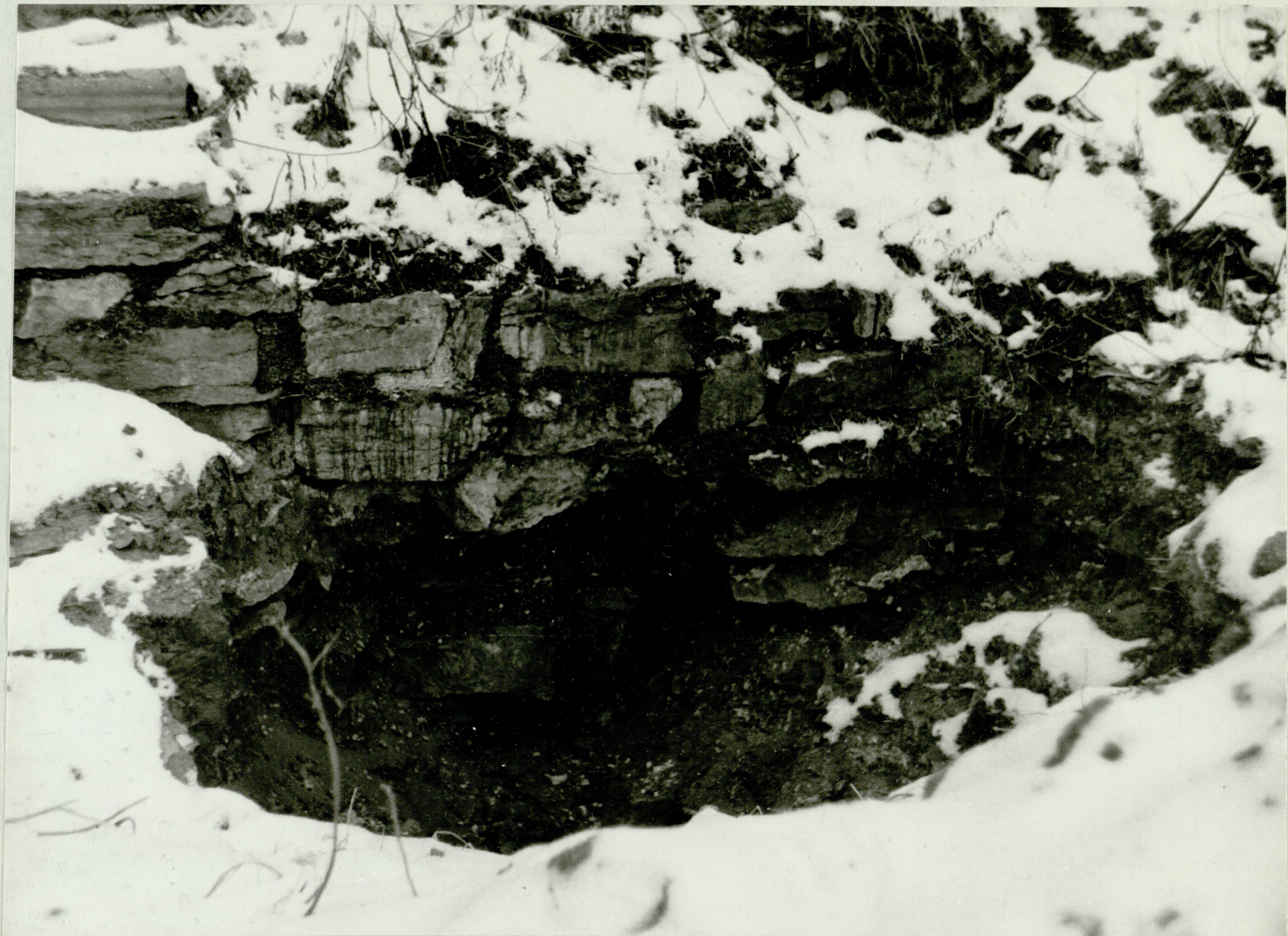
Рис. 9 Фундаменты северного фасада.
