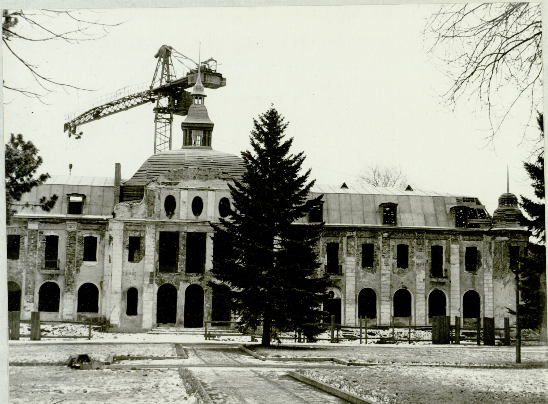
Рис.1 Северный фасад / Декабрь 1990 г./
