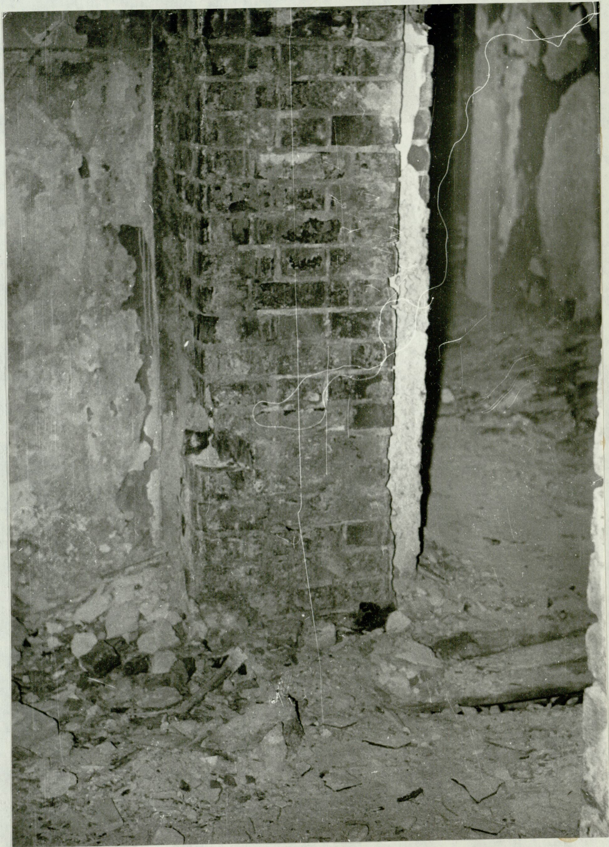
Рис.52 Выкол в нижней части стены.
