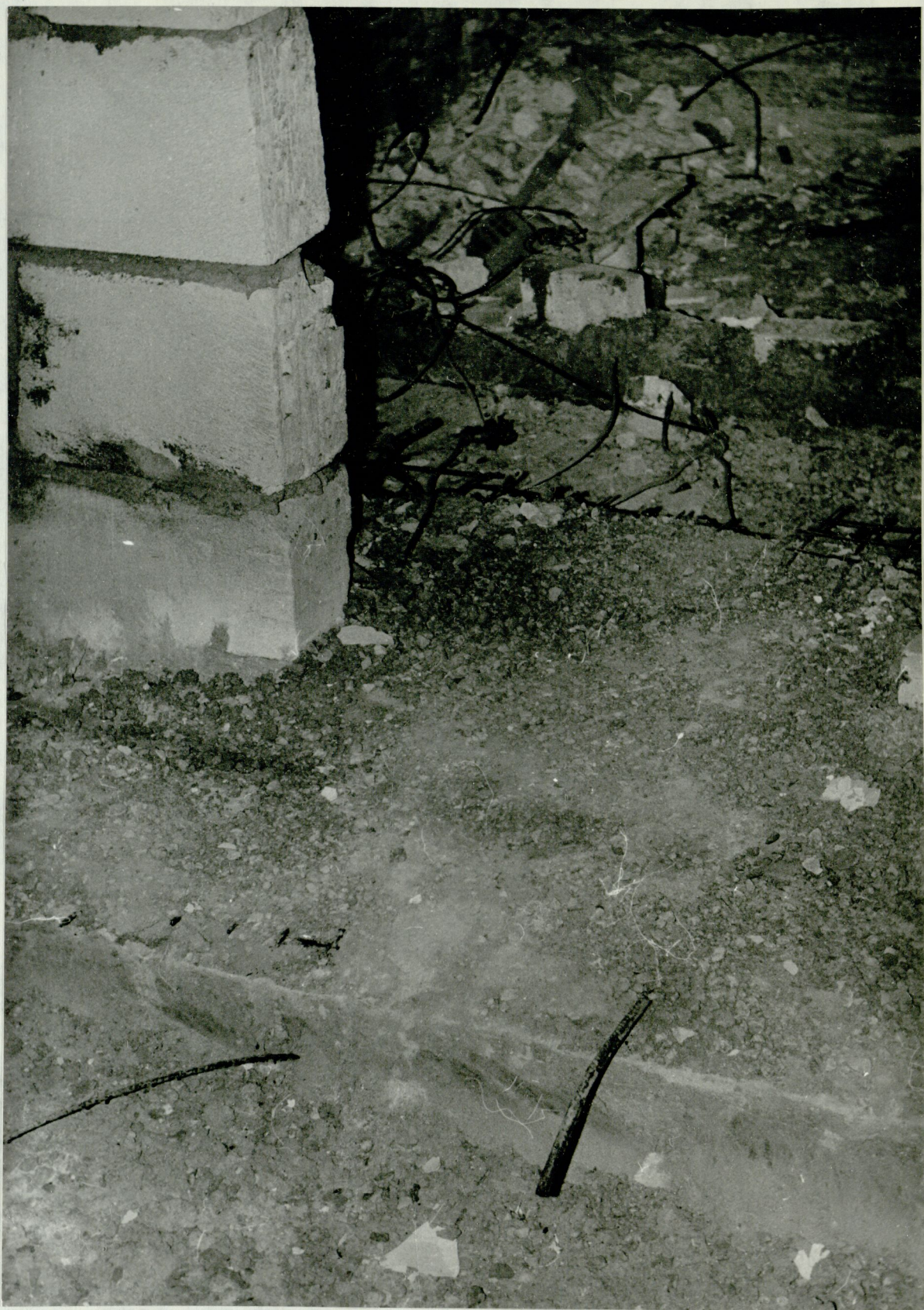
Рис.33 Бетонирование широкой балки.
