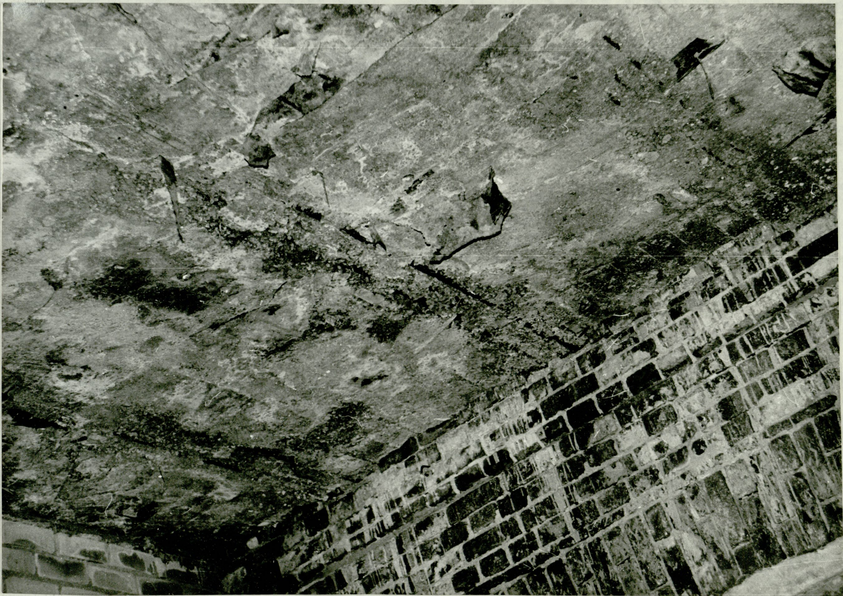
Рис. 35 Вид на нижнюю поверхность монолитной плиты.
