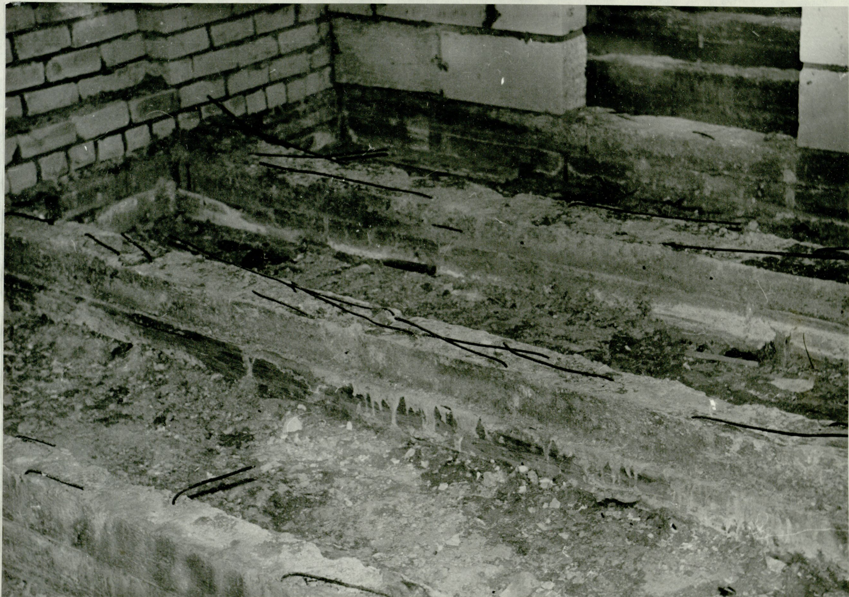
Рис.32 Опора балок заделаны в кладку.
