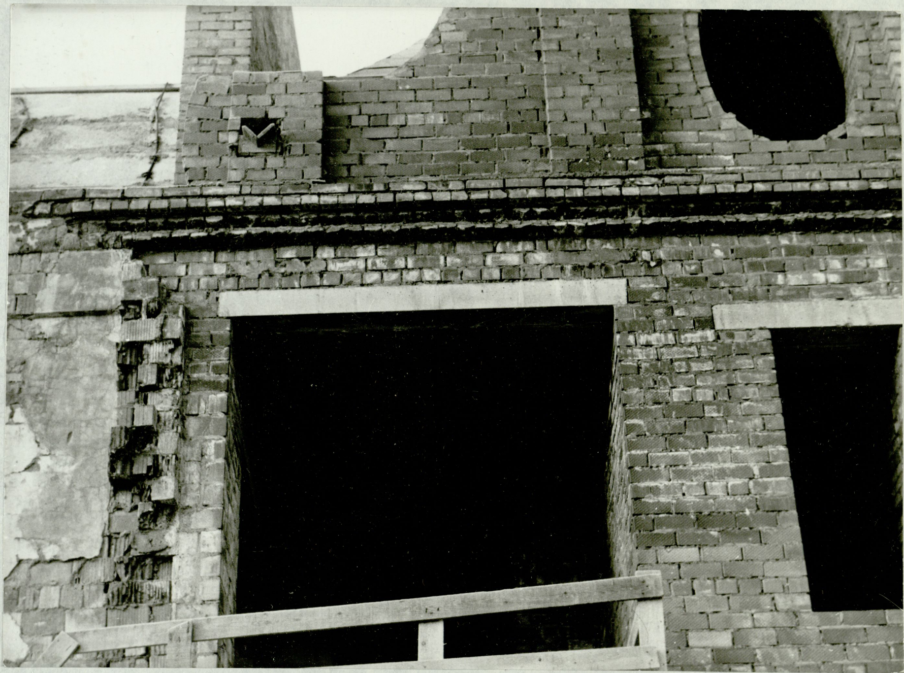
Рис.18 Ошибка в опирании перемычки.
