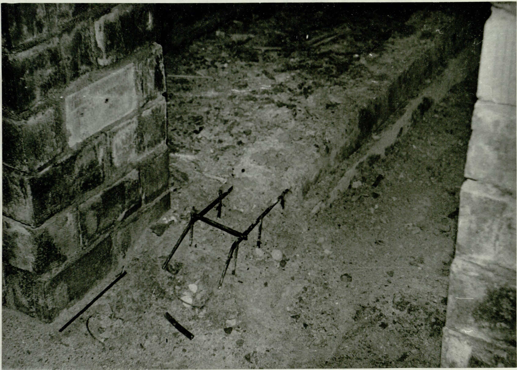
Рис. 37 Армирование коротких балок.
