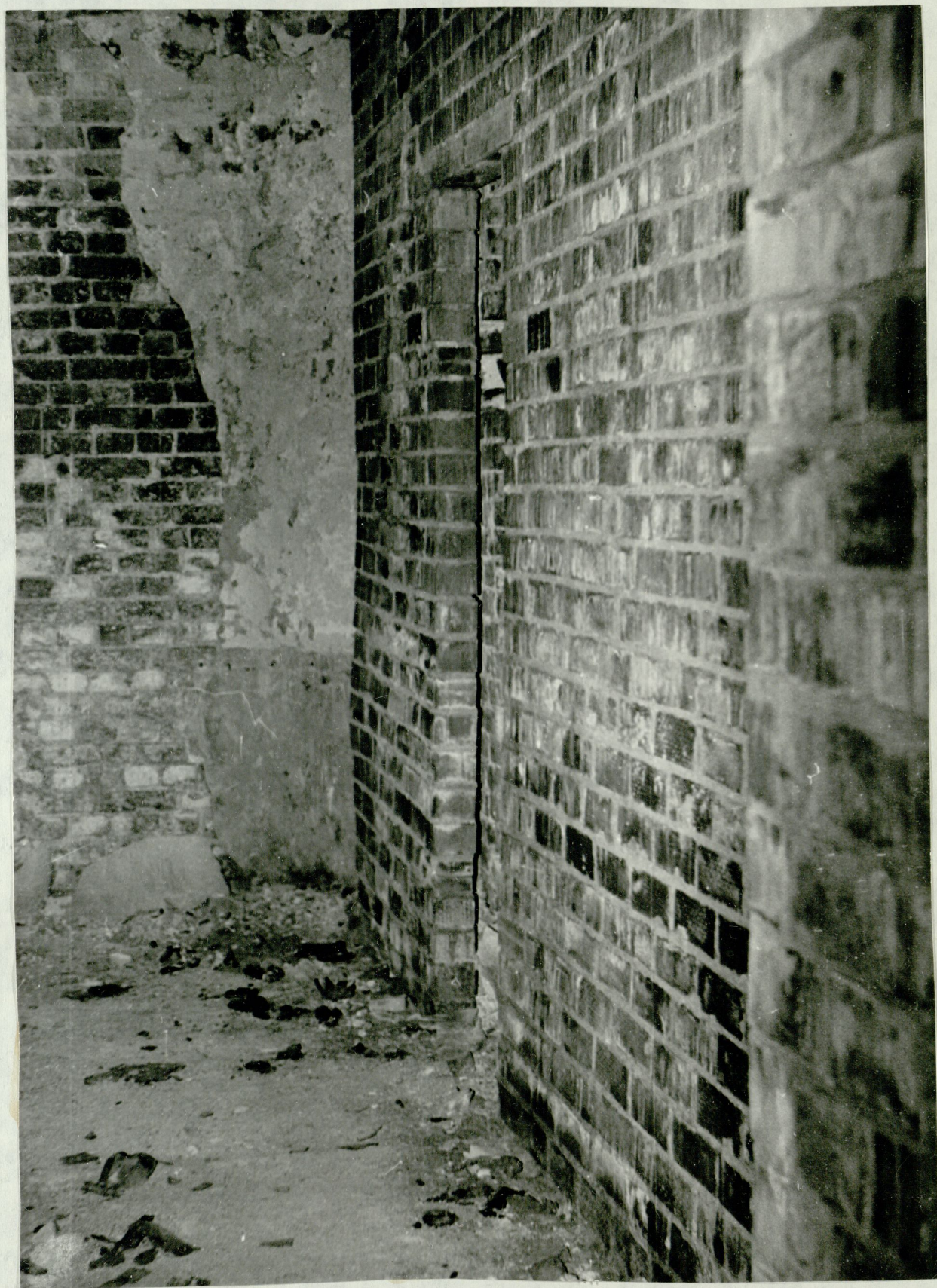
Рис. 39 Наклон тонкой перегородки около 9,5 см.
