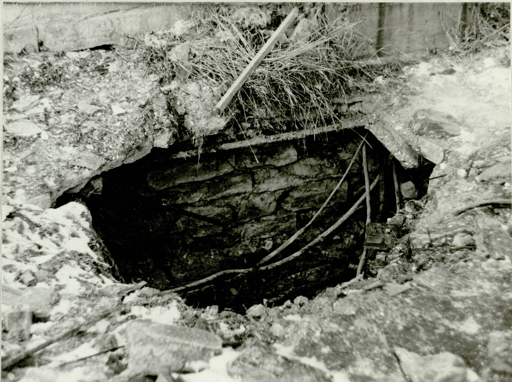
Рис. 54 Бутовый фундамент южной стены.
