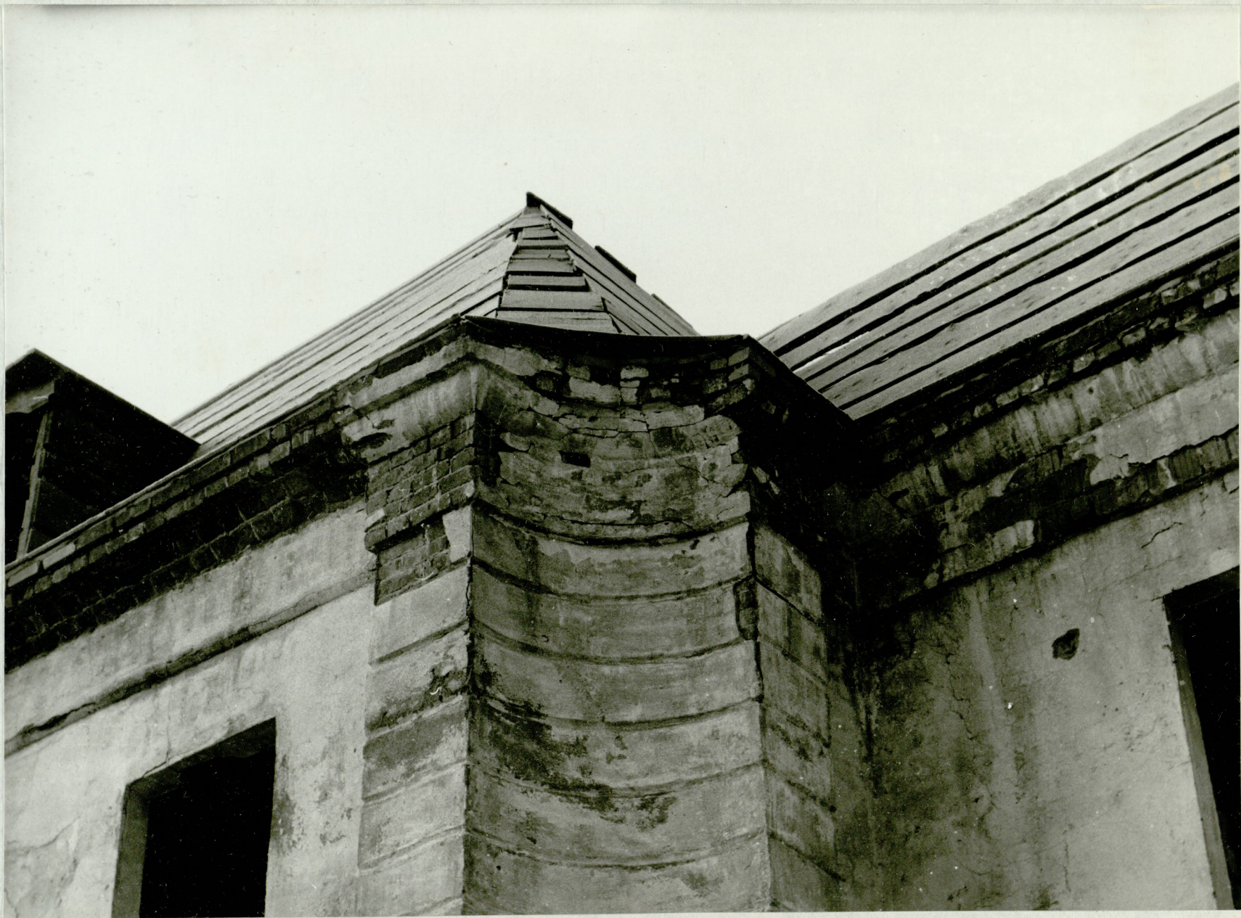
Рис. 17 Повреждение карниза.
