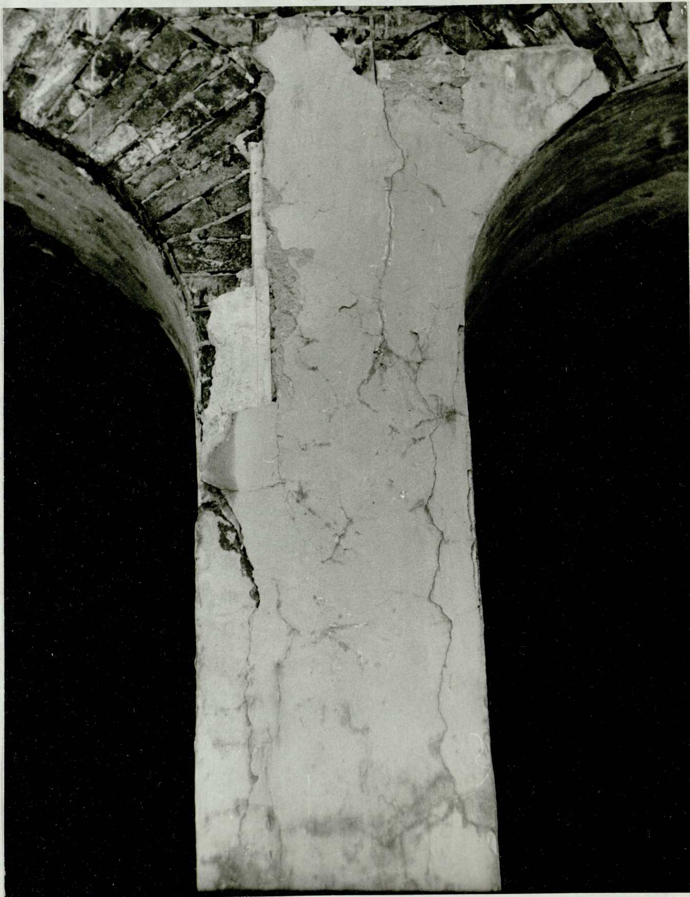
Рис.4 Повреждение штукатурки
