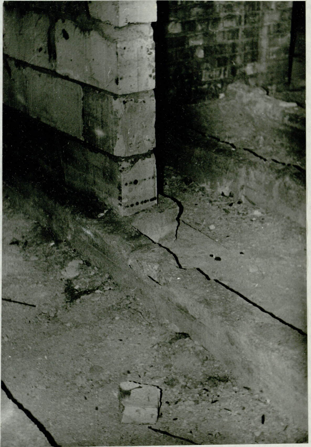
Рис.27 Армирование балки и опирание стенки.
