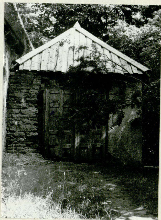
üksikale kabele Kassari kabeleaval.
